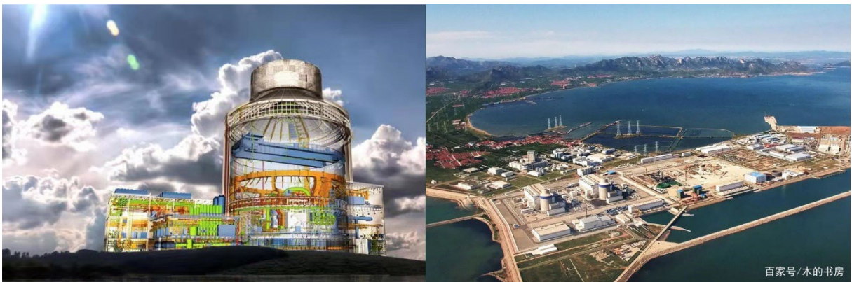
사진 1) 출처: 바이두바이자하오(百家号) 국가전력투자공사가 첨단 기술로 건설중인 산둥릉청 시다오만(山东荣城石岛湾)의 CA1400 시범 프로젝트
