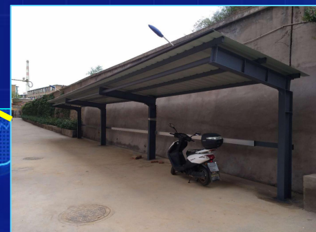
上海电力科技园园区
